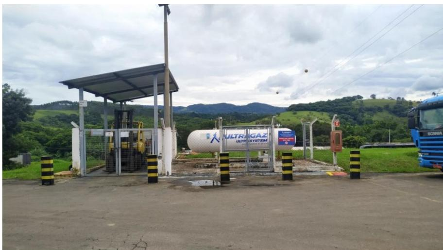
**Figura 8.** Central de armazenamento de GLP para abastecimento das empilhadeiras.
