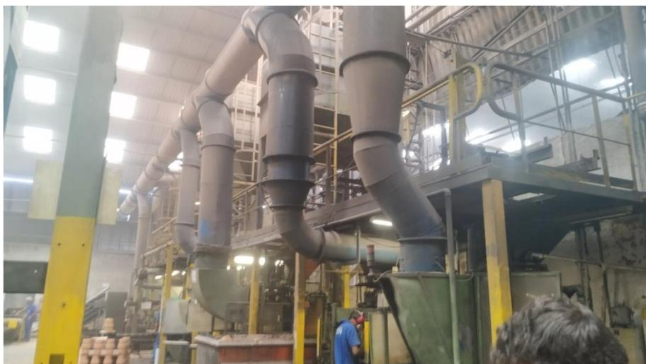
**Figura 3.** Vista parcial do sistema de exaustão do galpão da fundição.
