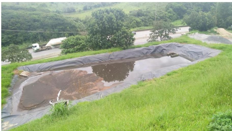
**Figura 12.** Bacia de contenção de águas pluviais.
