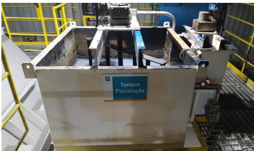
Figura 15. Tanque de flocação 1 e Lamella 1 da ETE Físico-Química.
