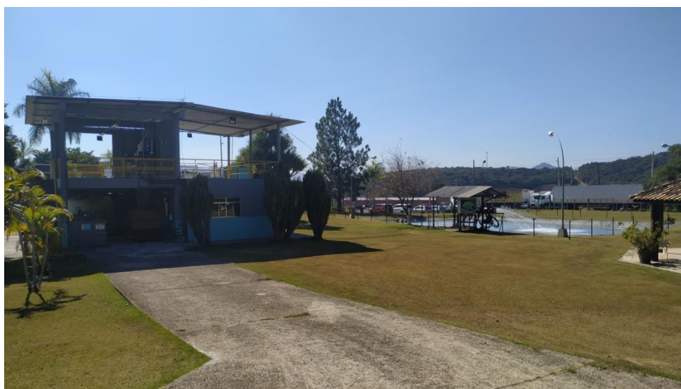
Figura 20. Vista da ETE Biológica e lagoa de estabilização/decantação.
