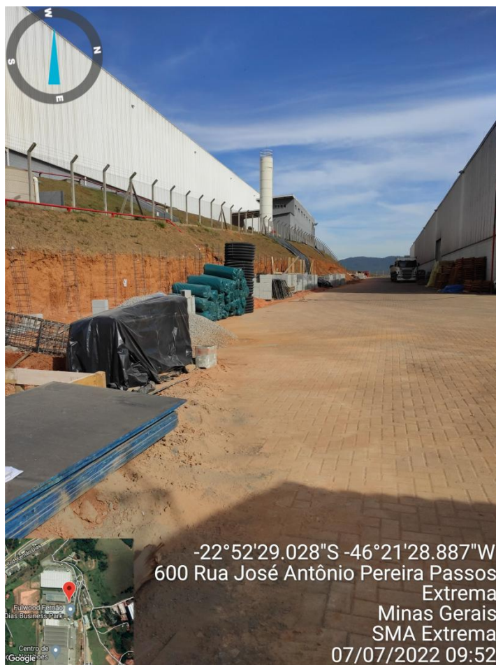
Figura 2. Obras de alargamento da servidão de passagem.
