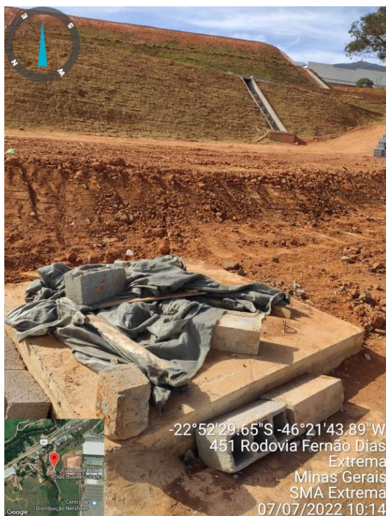
Figura 12. Caixa de passagem localizada na divisa do imóvel com a rua. Início do lançamento de drenagem até o córrego local.
