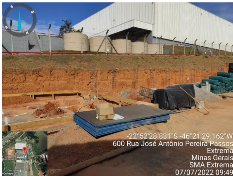
Figura 1. Obras para realocação de portaria e alargamento da via.
