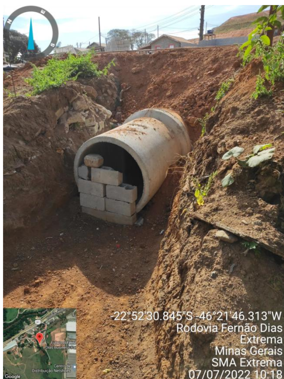
Figura 13. Saída do sistema de drenagem em fase de finalização.
