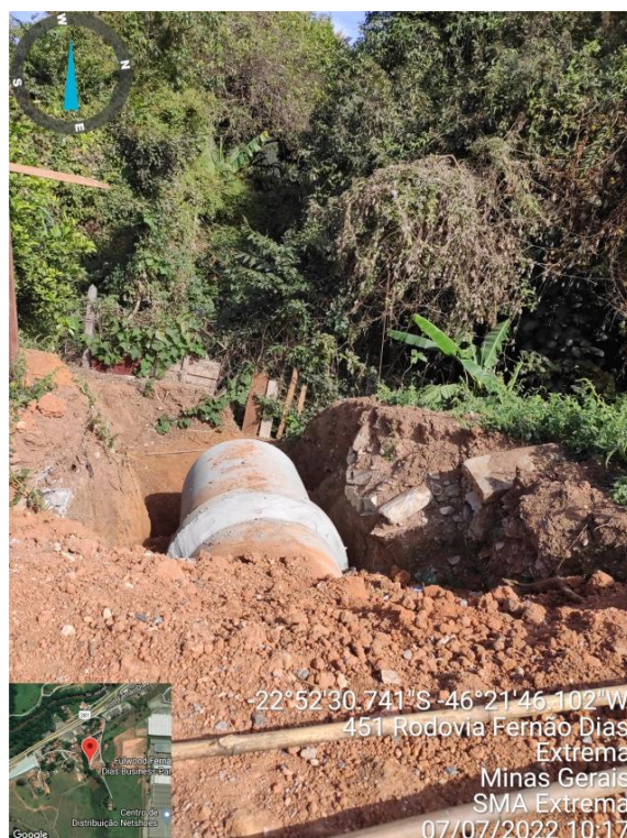
Figura 14. Saída do sistema de drenagem em fase de finalização.
