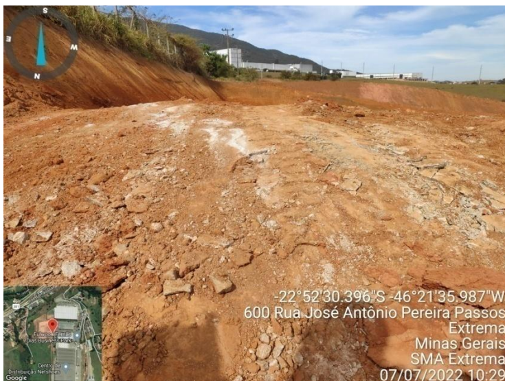
Figura 7. Área com material rochoso a ser removido.
