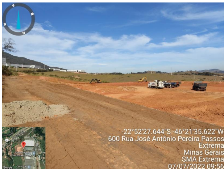
Figura 5. Vista da porção Sudoeste do empreendimento.
