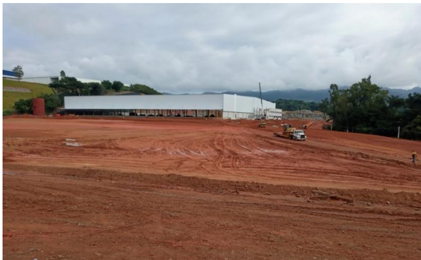
Figura 1. Vista frontal do empreendimento (Galpão A aos fundos).
