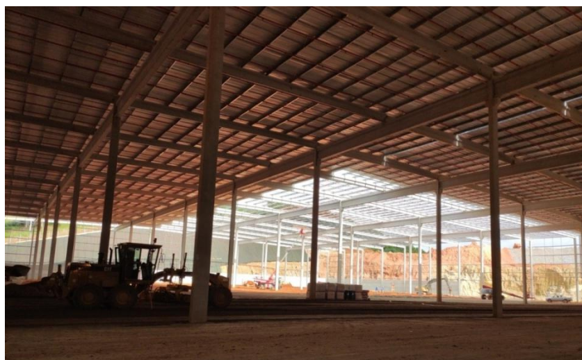
Figura 2. Vista interna do Galpão A (em construção).
