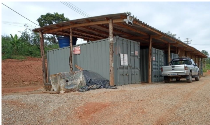
Figura 3. Canteiro de Obras 1 do empreendimento.
