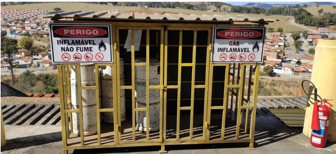
Figura 17. Local de armazenamento de GLP para suporte às empilhadeiras a gás
