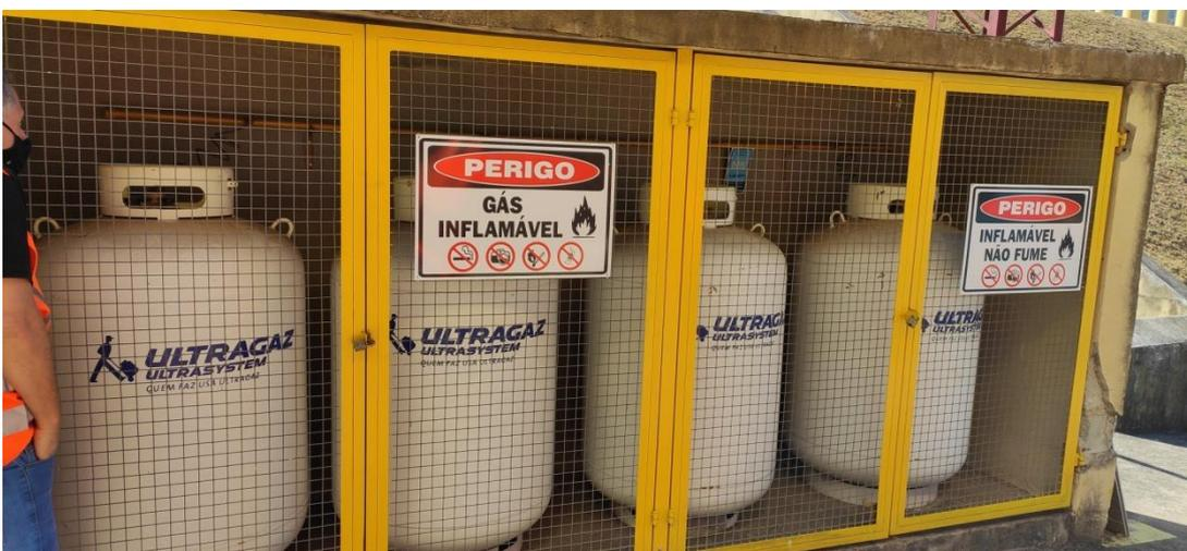
Figura 18. Local de armazenamento de GLP para suporte a produção de alimentos
