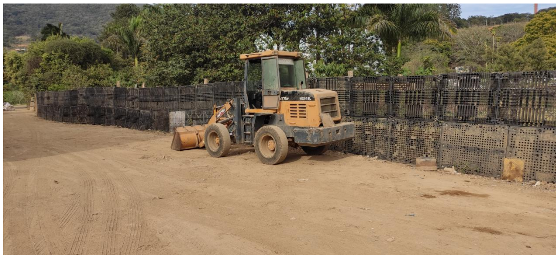
Figura 10. Equipamento de apoio para movimentação de materiais (pá carregadeira).
