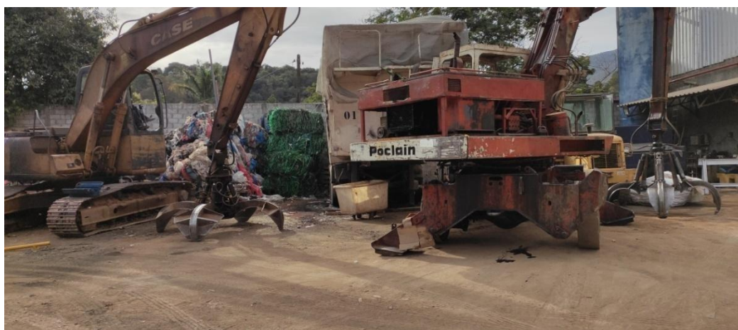
Figura 9. Equipamento de apoio para movimentação de materiais (escavadeiras) (em manutenção no momento da vistoria).
