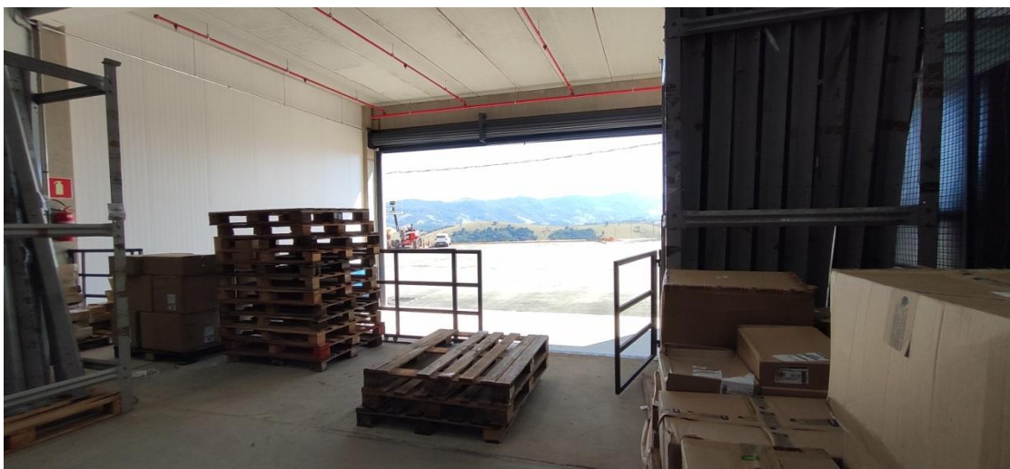
Figura 2. Docas de recebimento de produtos.
