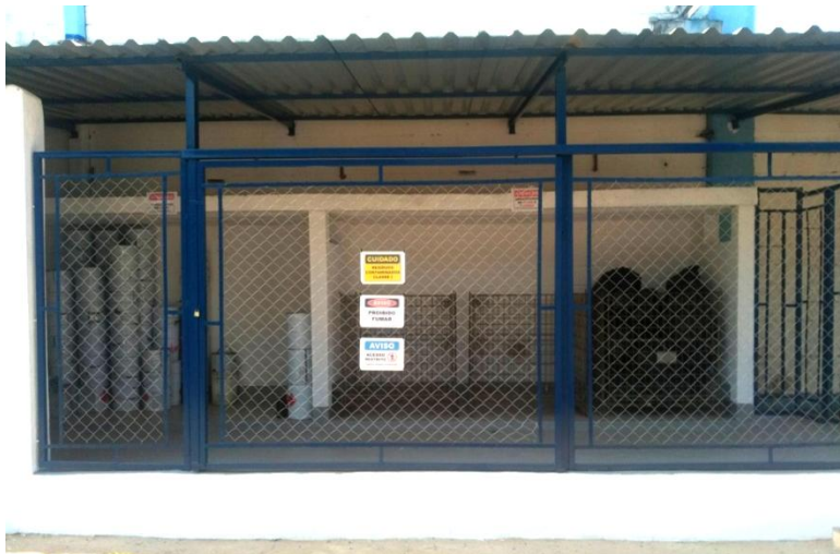
Figura 14. Área de armazenamento de embalagens/resíduos perigosos, em 10/09/2020
