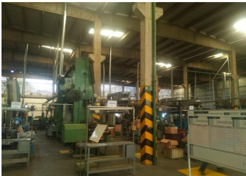
Figura 4. Detalhe das chaminés dos exaustores provenientes dos fornos e estufas
