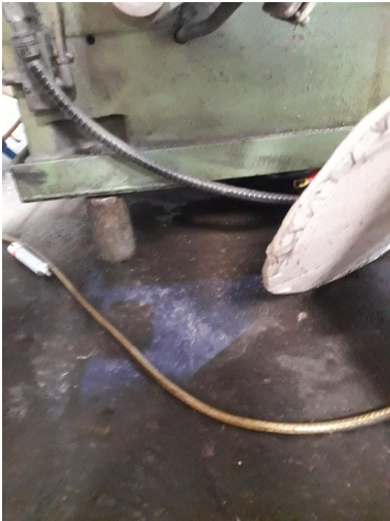
Figura 20. Equipamentos com vazamento de água com óleo, em 04/12/2019.
