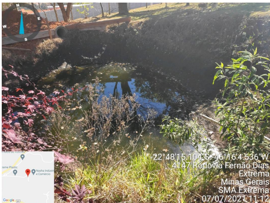
Figura 15. Bacia de contenção do sistema de drenagem de águas pluviais.
