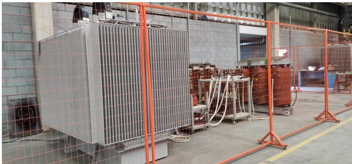
Figura 10. Área para realização de testes.
