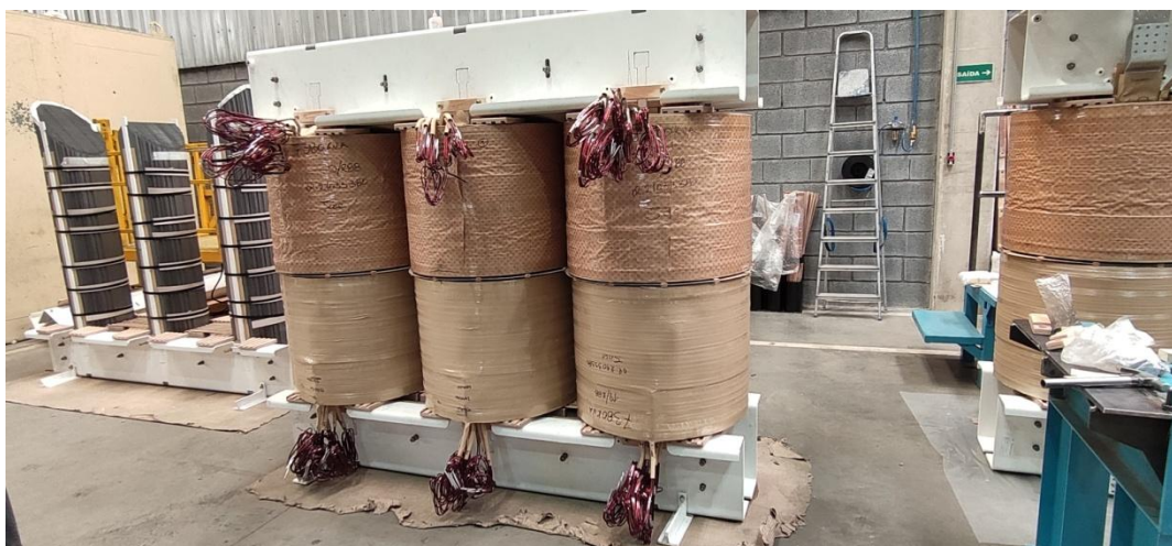
Figura 3 . Área para montagem da parte ativa.
