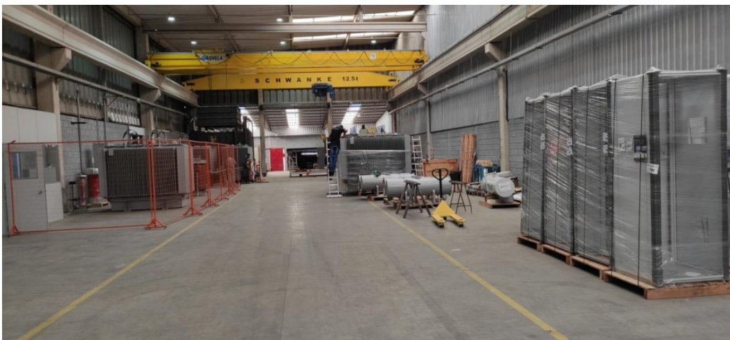
Figura 1 . Área interna do empreendimento.
