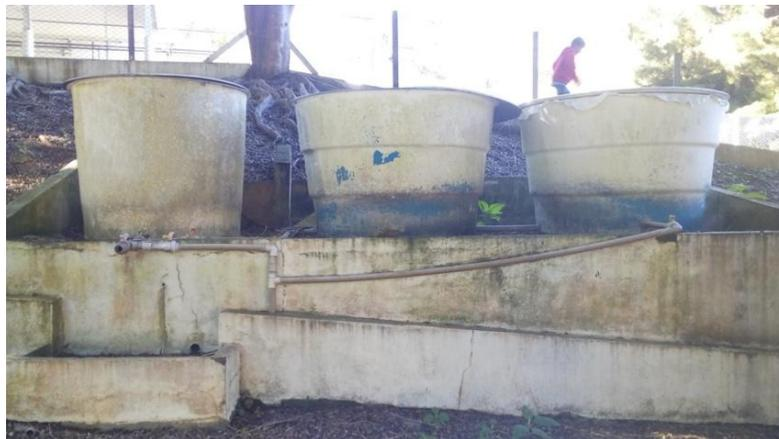
Figura 3. Reservatórios existentes para armazenamento de soro
