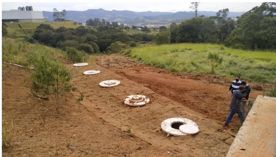
Figura 8. Sumidouros da ETE
