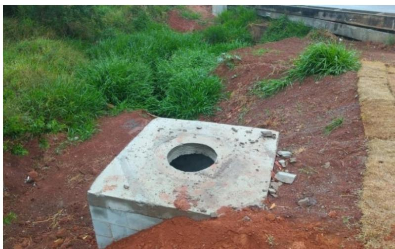
Figura 12. Lançamento da rede interna de águas pluviais, próximo à Rua José Antônio Pereira Passos
