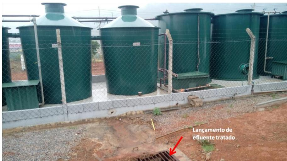
Figura 8. ETE do condomínio logístico, com indicação do ponto de lançamento de efluente tratado.
