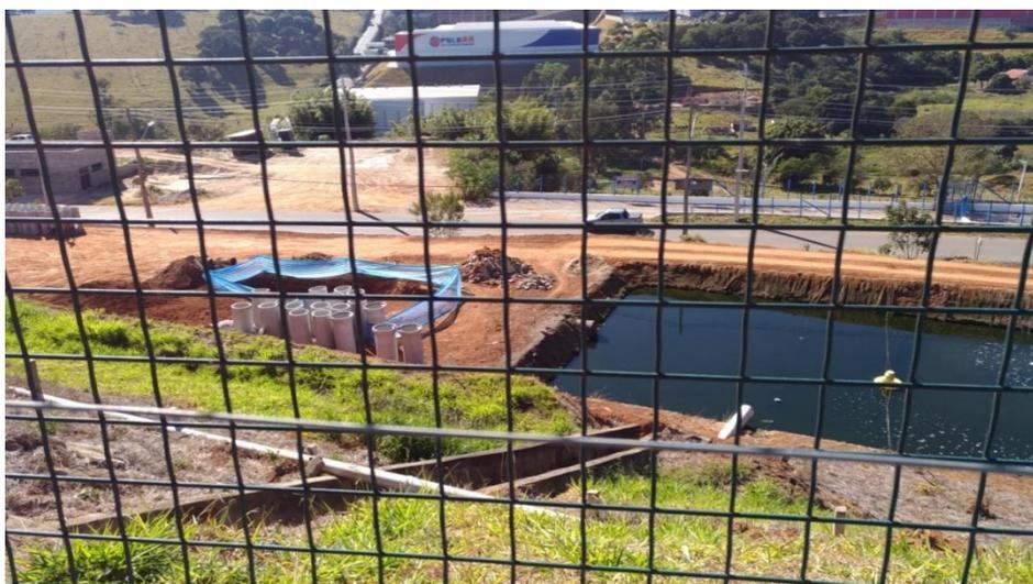
Figura 14. “Piscina 03” (à direita) e área onde estaria a “Piscina 04” (à esquerda) aterrada, com presença de manilhas para ligação da rede de águas pluviais. Arquivo SMA vistoria 28.05.2020.
