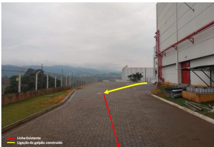
Figura 7. Vista dos fundos da área ampliada, com indicação da ligação à rede interna de coleta de esgoto.
