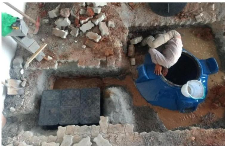
**Figura 4. Instalação de estrutura de contenção de efluentes da sala de recarga de baterias, segundo informado em vistoria.**
