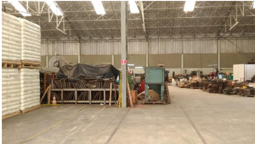
Figura 1. Vista interna da área do galpão do empreendimento.
