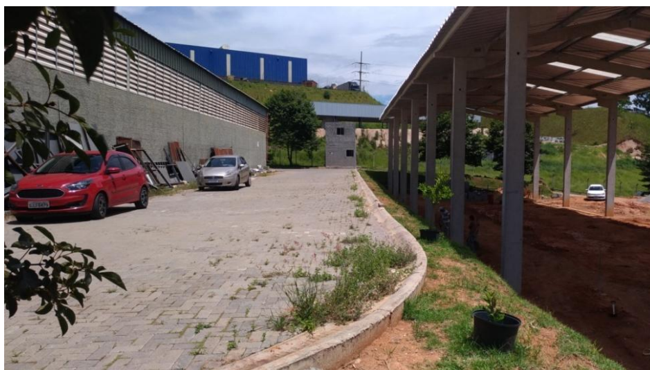
Figura 6. Área externa do empreendimento e local de construção de novo galpão
