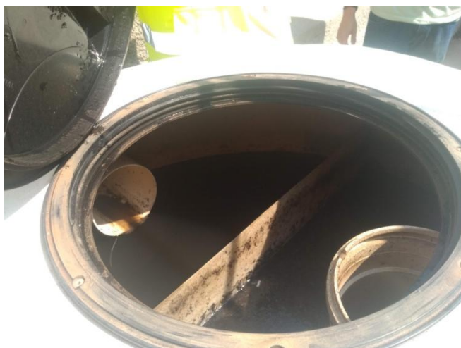
Figura 10. Tanque de contato/ desinfecção. (ponto de coleta da saída do sistema de tratamento)
