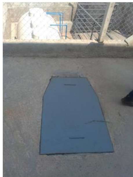
Figura 9. Entrada de efluente na ETE
