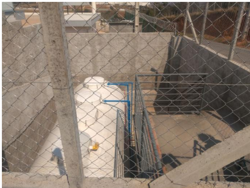
Figura 8. ETE modular de tratamento de efluente sanitário
