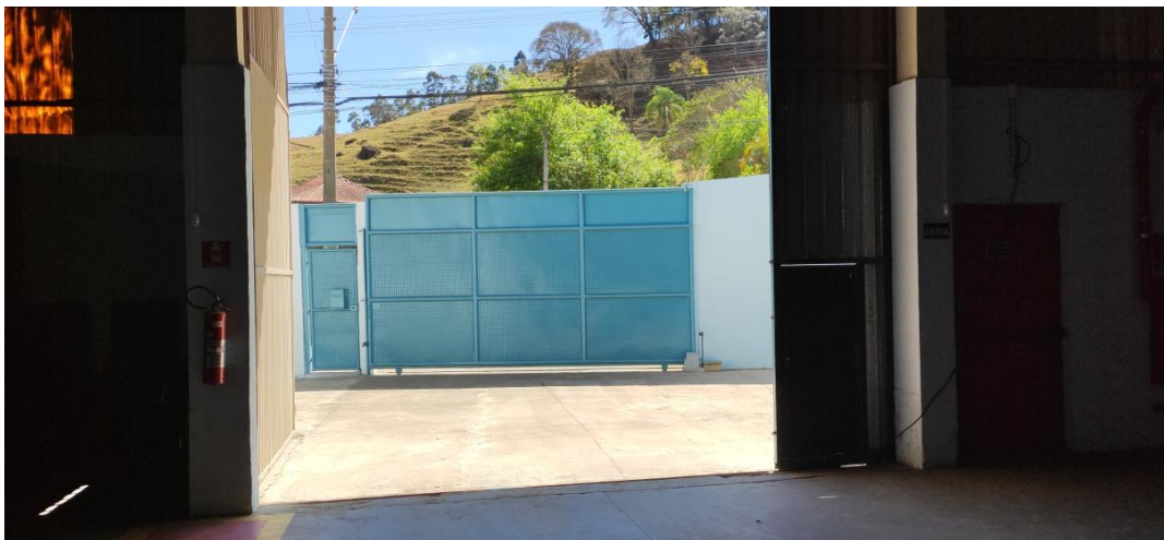
Figura 1 . Área de entrada do empreendimento.
