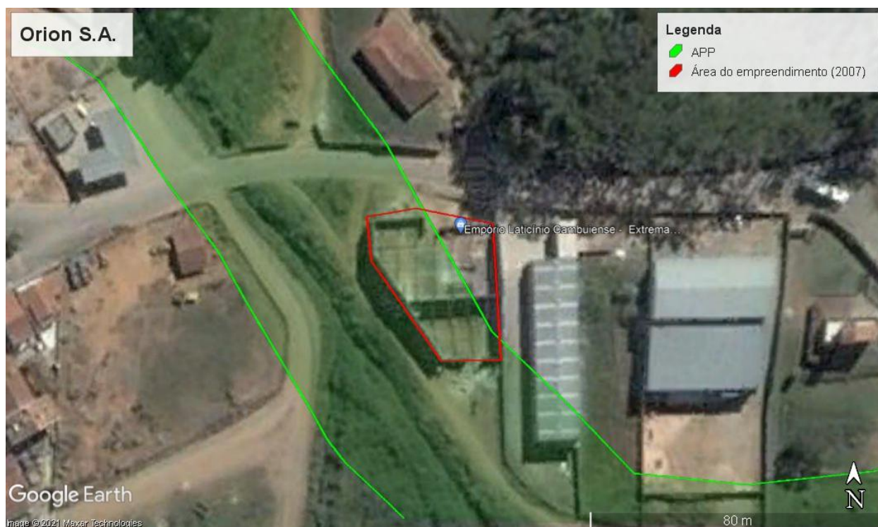
Figura 4. Imagem histórica das estruturas do galpão e do pátio pavimentado utilizado pelo empreendimento, construídos anteriormente a data de 22 de julho de 2008.
