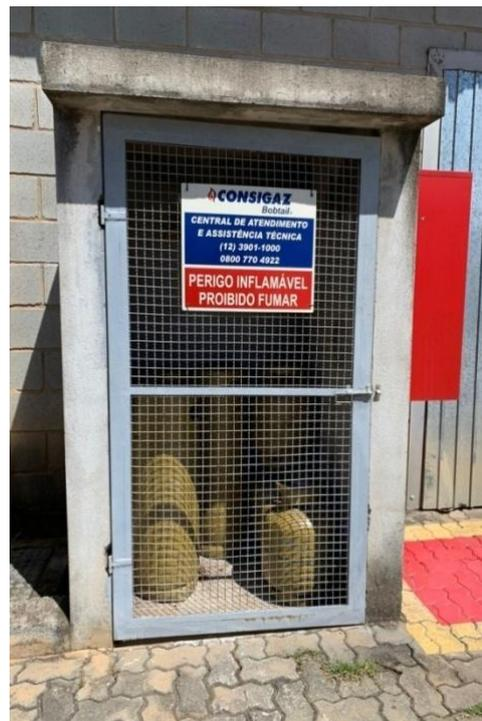
Figura 19. Local de armazenamento de GLP
