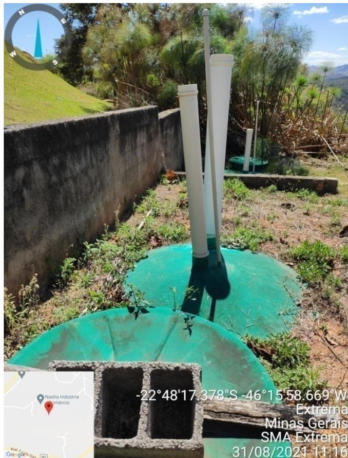
Figura 21. Sistema de tratamento de efluentes sanitários.
