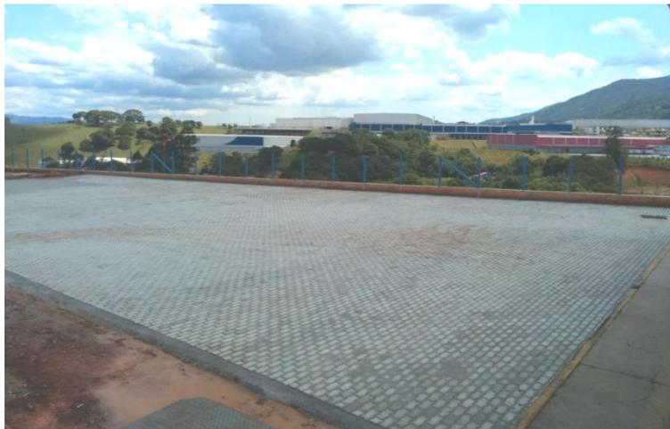
**Figura 9. Execução de pavimento com bloquetes intertravados**
