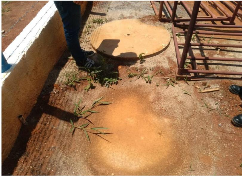
**Figura 8. Tampas da localização do sistema de tratamento de efluentes (biodigestor) e sumidouro**
