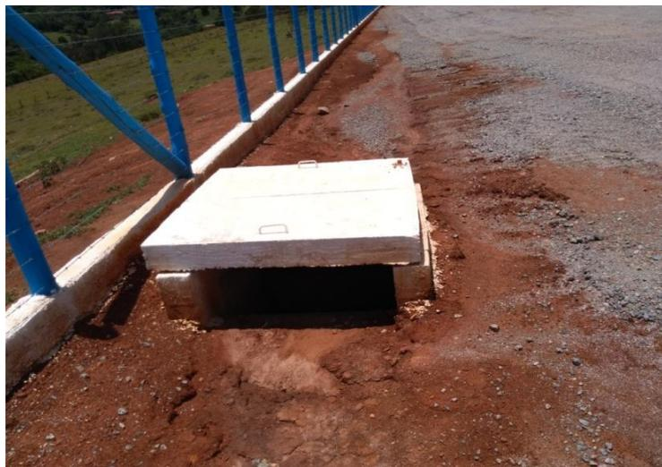
**Figura 10. Ponto de coleta final e redirecionamento de águas pluviais**
