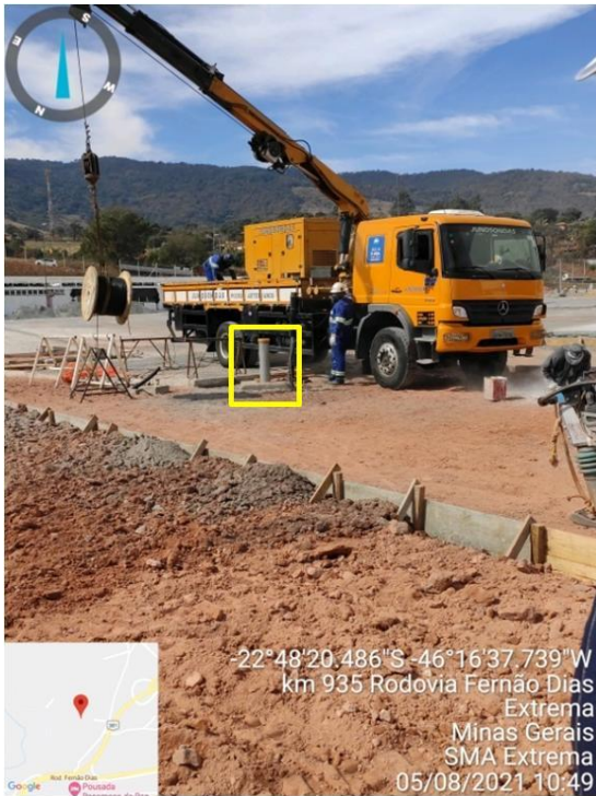
Figura 12. Instalação do poço tubular
