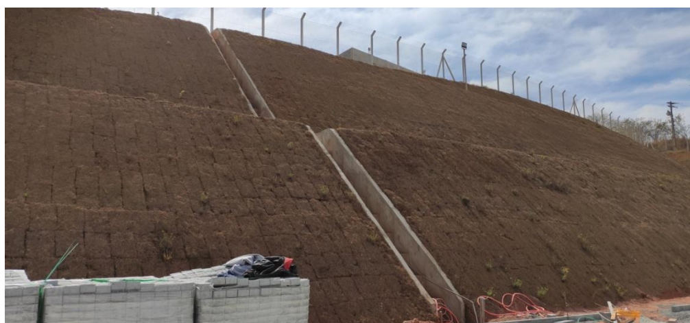
Figura 11. Talude da área norte com revegetação instalada.
