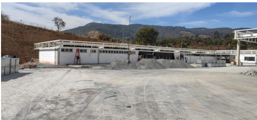
Figura 8. Construção das áreas de apoio.
