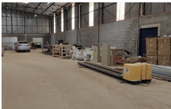
Figura 3. Interior do canteiro de obras.
