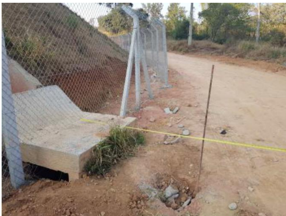
Figura 17. Adequação do cercamento do terreno, conforme apresentado pelo empreendedor em 31/08/2021.
