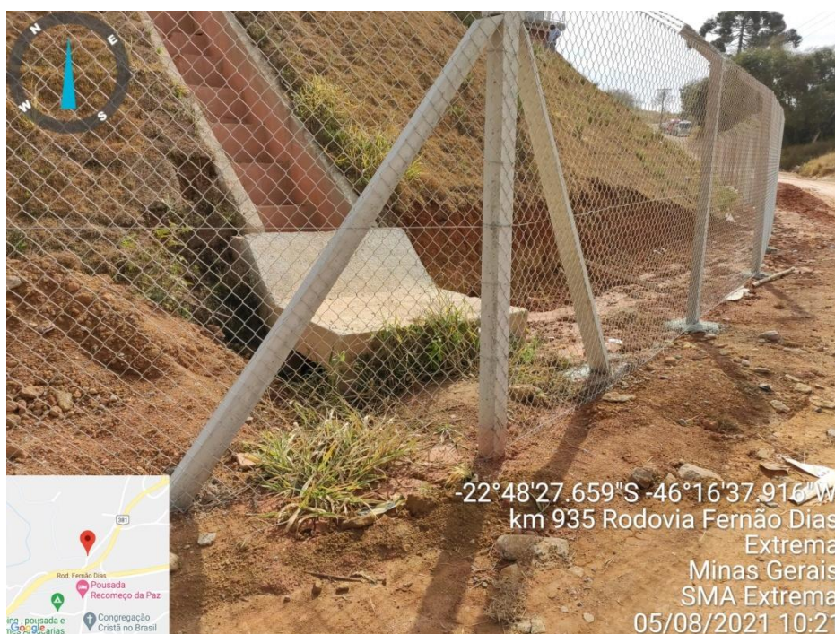
Figura 16. Ponto de intervenção em APP – Cercamento do terreno.
