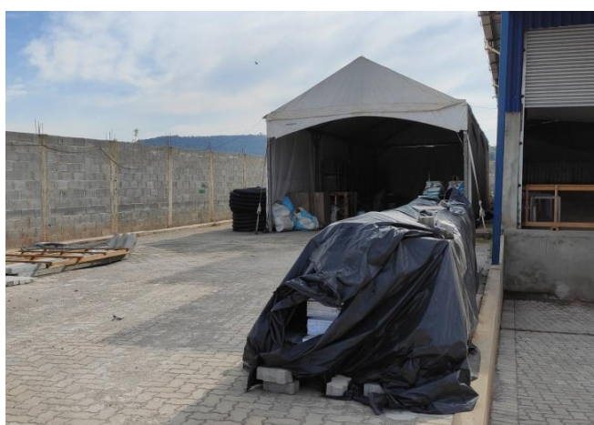
Figura 4. Área de apoio ao canteiro de obras.
