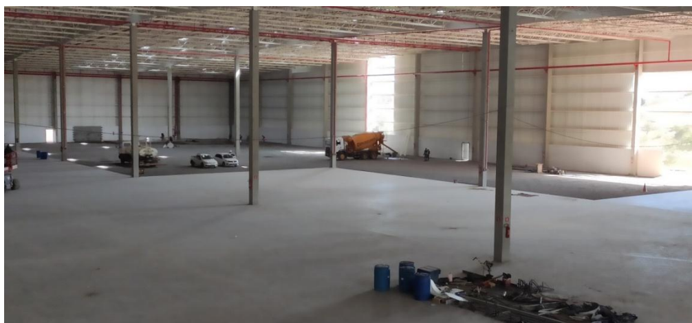
Figura 10. Interior do galpão em finalização de piso.
