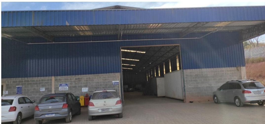
Figura 1. Entrada do galpão do canteiro de obras.
