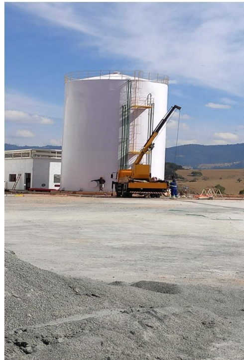
Figura 13. Reservatório de Água
