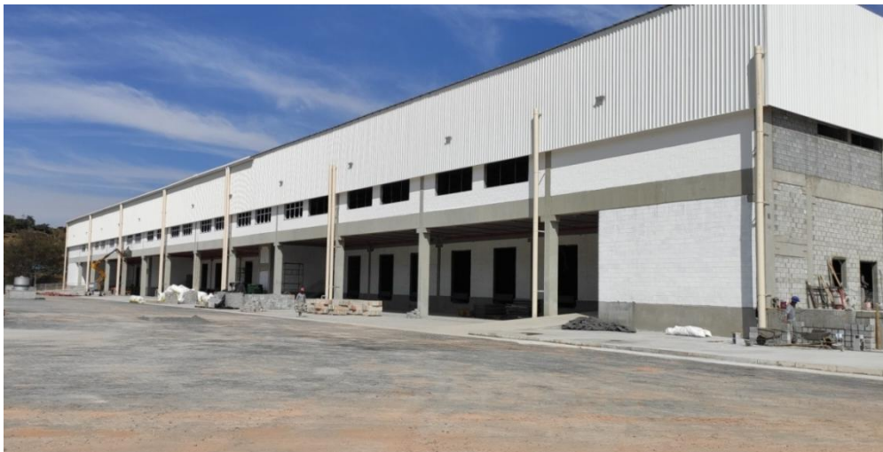
Figura 7. Galpão logístico/industrial em construção
