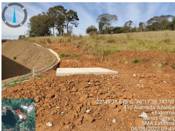
Figura 8. Base onde será instalado o tanque de abastecimento de água potável.
