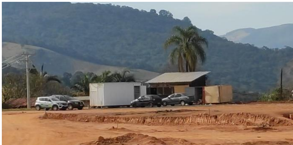
Figura 1. Canteiro de obras.
