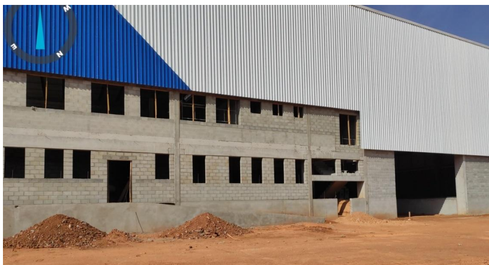
Figura 3. Vista lateral do galpão 1.
