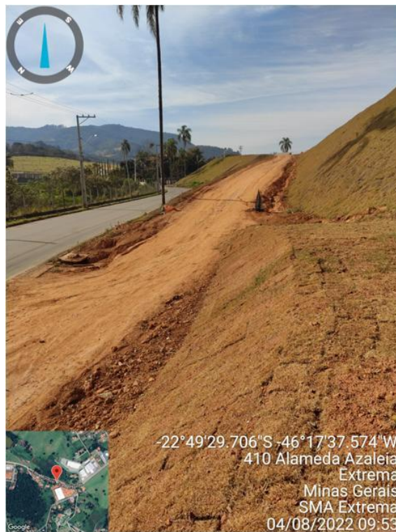
Figura 10. Vista da rampa de acesso ao empreendimento (em construção).
