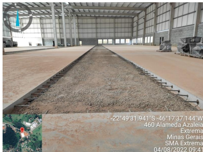
Figura 5. Preparo do piso para recebimento de maquinários.
