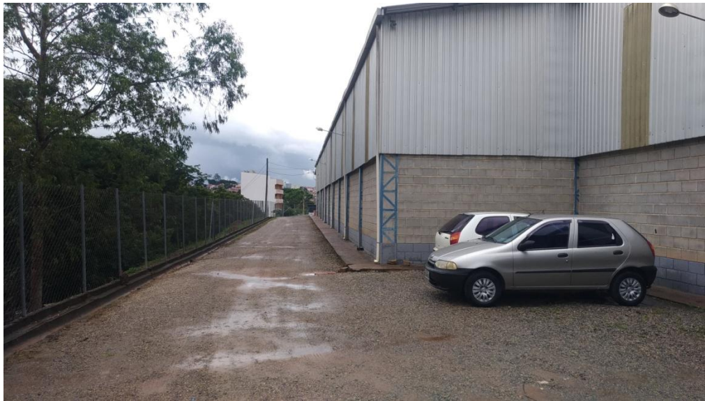
Figura 7. Vista lateral do galpão, com coleta de águas pluviais e solo permeável.
