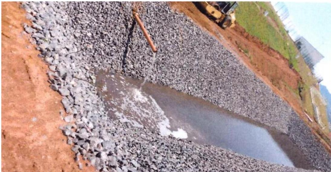
Figura 17. Lançamento do efluente tratado em sumidouro/lagoa de infiltração
