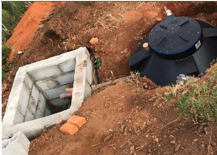
**Figura 5. Sistema de tratamento de efluentes sanitários do empreendimento em instalação (09/12/2020).**
