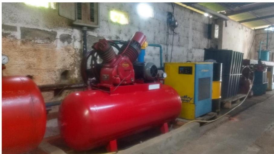
Figura 8. Compressor Wayne Industrial, com contenção para prevenção em caso de vazamentos.
