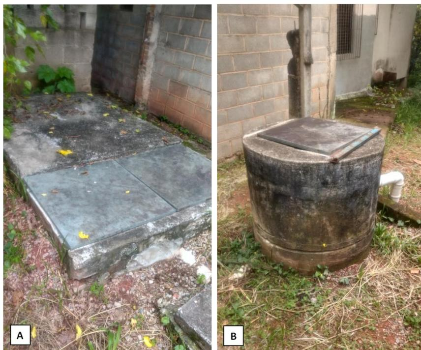
Figura 12. Sistema de tratamento de efluentes sanitários (A - tanque séptico e B - filtro anaeróbico) anteriormente a execução de adequações
