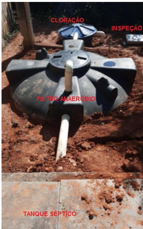
Figura 13. Sistema de tratamento efluentes sanitários após a execução de adequações
