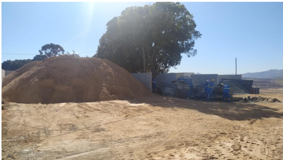
Figura 2. Baias de armazenamento de matérias-primas
