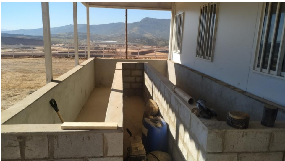
Figura 8. Tanque de testes de cura do concreto
