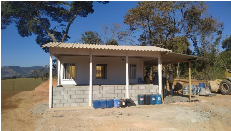
Figura 7. Laboratório de análise de concreto produzido
