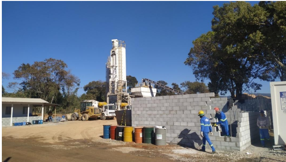
Figura 1. Vista da central dosadora de concreto, com finalização da instalação das baias
