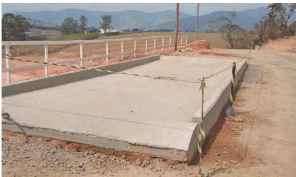
Figura 9. Sistema de lava rodas, na portaria de acesso. Fonte: empreendedor
