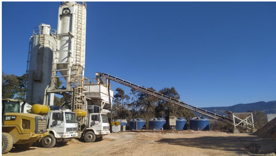
Figura 4. Detalhe dos equipamentos (caminhões betoneira, trator pá-carregadeira, esteira e silos)
