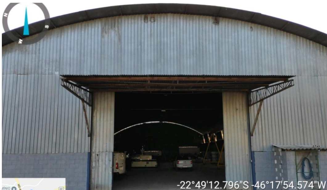
Figura 1 . Entrada do galpão do empreendimento.
