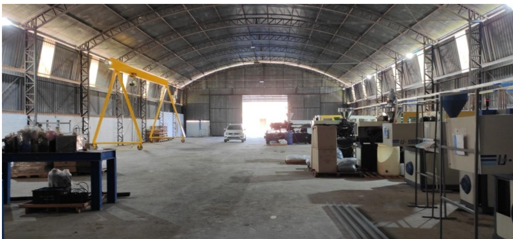
Figura 2 . Vista interna do empreendimento.
