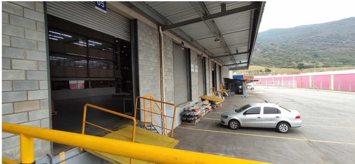
Figura 8. Vista externa da área de recebimento/expedição de produtos.
