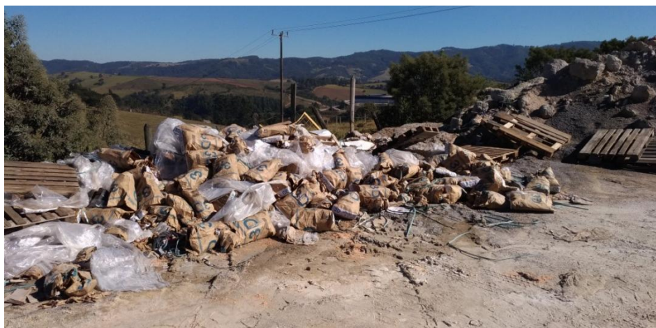
Figura 4. Armazenamento transitório inadequado de resíduos recicláveis (papelão e plástico) em terreno sem cobertura e permeável.
