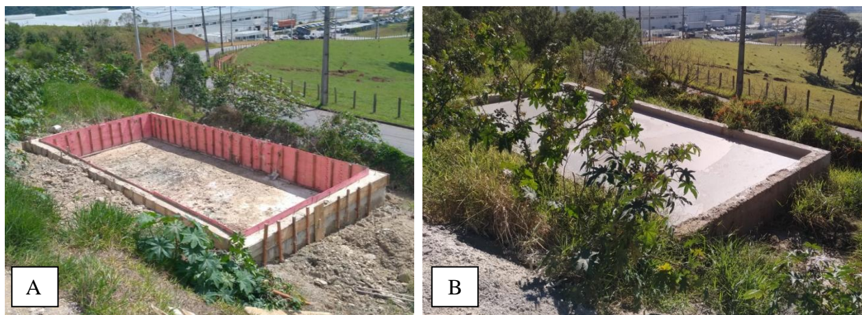
Figura 6. Registro de Obras de restauro na bacia de contenção
