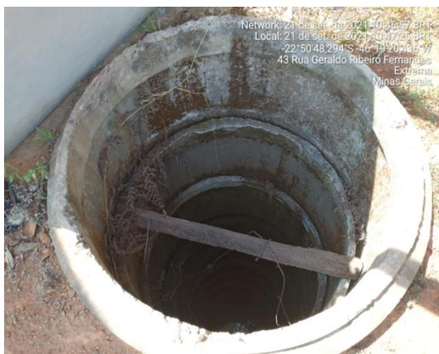
**Figura 17 - Poço para captação de águas subterrâneas desativado (aberto para vistoria e registro fotográfico)**
