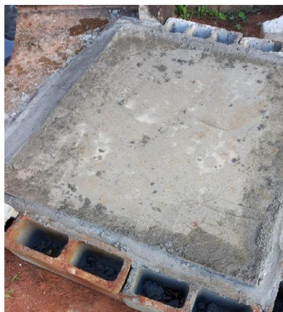
**Figura 18 - Poço após realização de tamponamento provisório**
