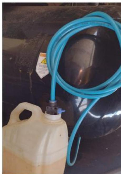
Figura 14. Contenção contra vazamentos de água de purga do compressor
