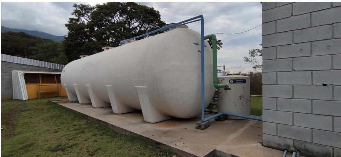
Figura 12. Estação de tratamento de efluentes sanitários.
