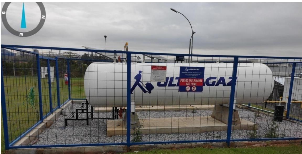
Figura 14. Central de armazenamento de GLP.
