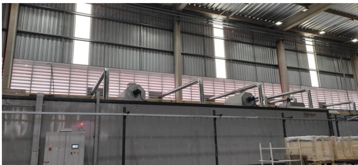
**Figura 3. Sistema de exaustão da linha de pintura.**
