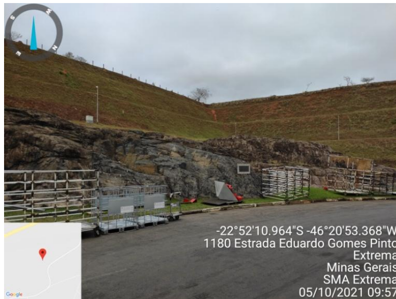
Figura 5. Área com material rochoso, que será mantido segundo Projeto Arquitetônico
