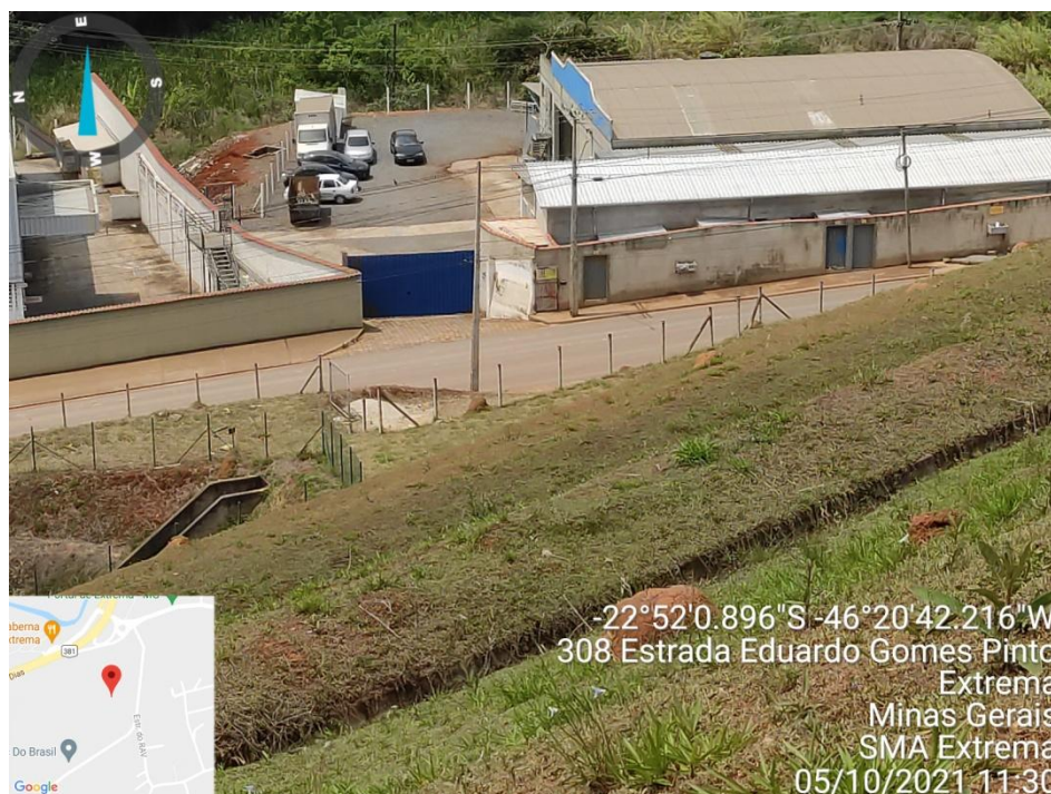
Figura 16. Local de realocação da ETE atual e instalação de novo módulo de ETE para a ampliação do empreendimento
