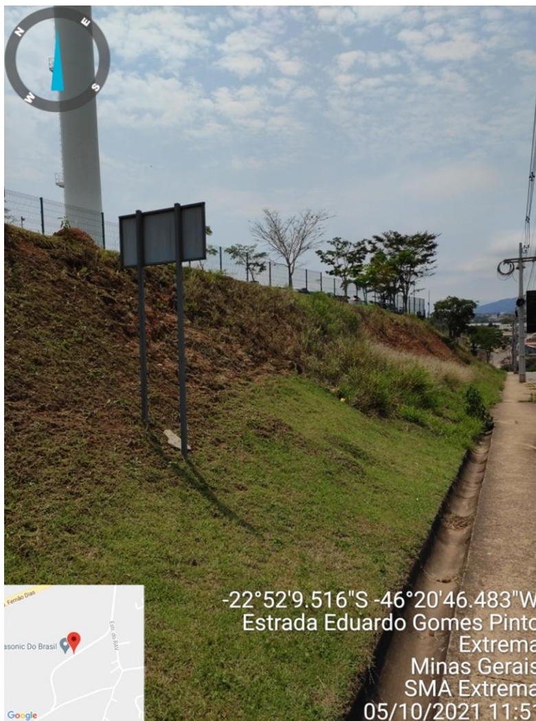
Figura 6. Local de execução de alça de acesso para a portaria 2 (a construir)
