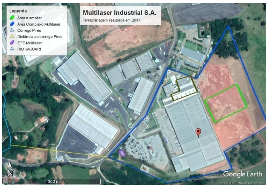
Figura 6. Terreno depois da realização da terraplanagem na área. (Fonte: Google Earth Pro, nov/2017)
