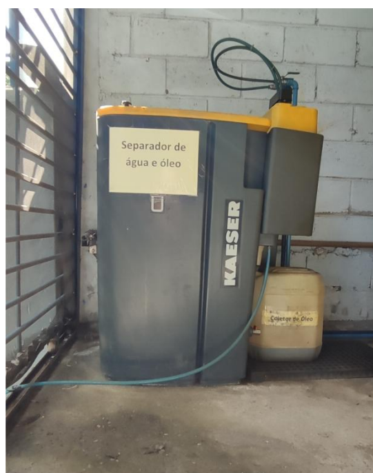
Figura 11. Sistema de separação de água e óleo
