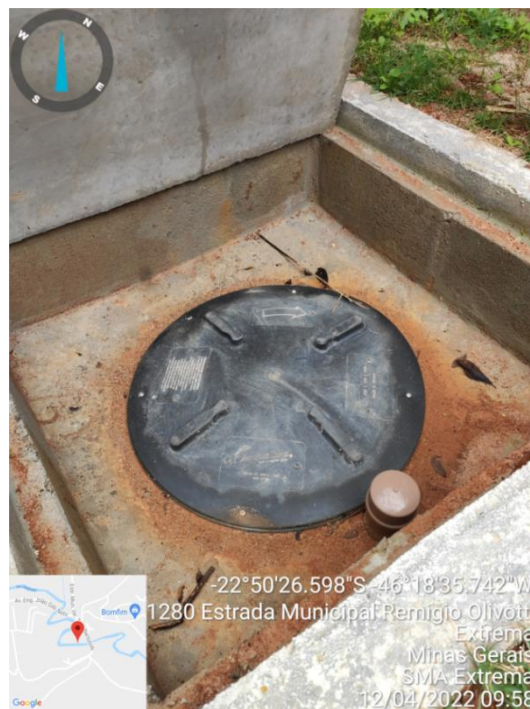
Figura 16. Local de instalação do Biodigestor.
