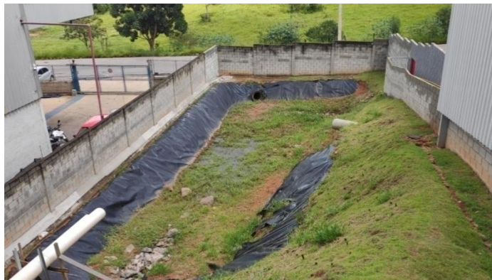
Figura 7. Tanque de retardo de águas pluviais
