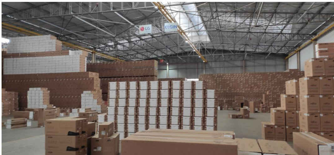
Figura 2. Visão geral de um dos módulos da área de estocagem.
