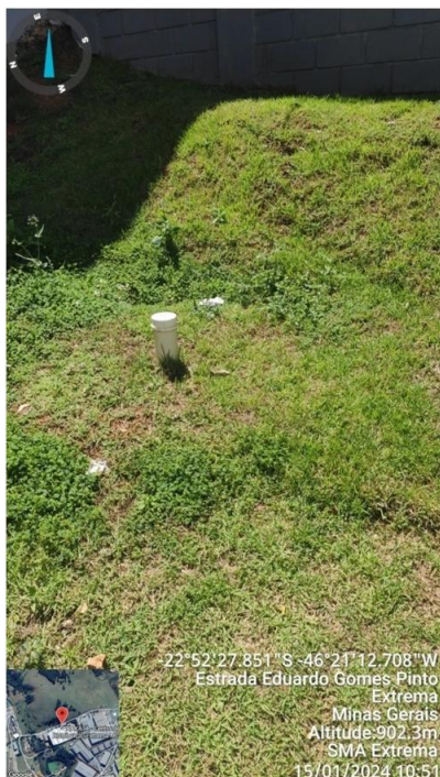
Figura 11. Biodigestor para atendimento a portaria
