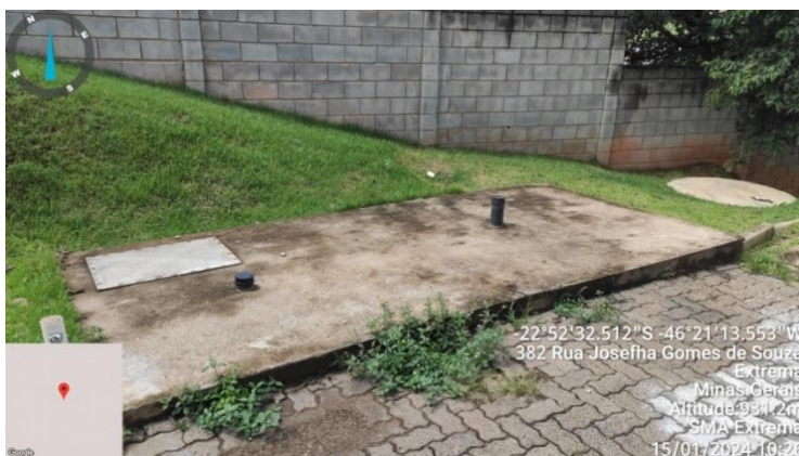
Figura 9. Sistema de tratamento da área do galpão , com localização do sumidouro tubular
