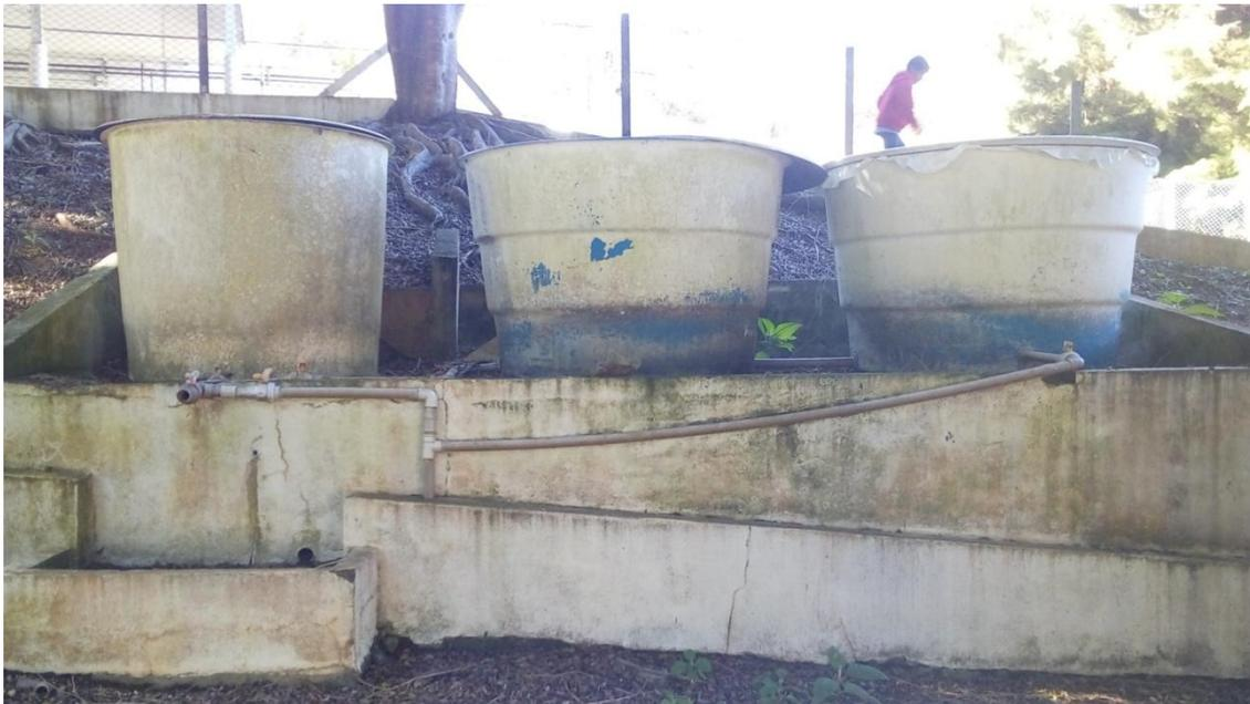
Figura 5. Reservatórios existentes de armazenamento de soro
