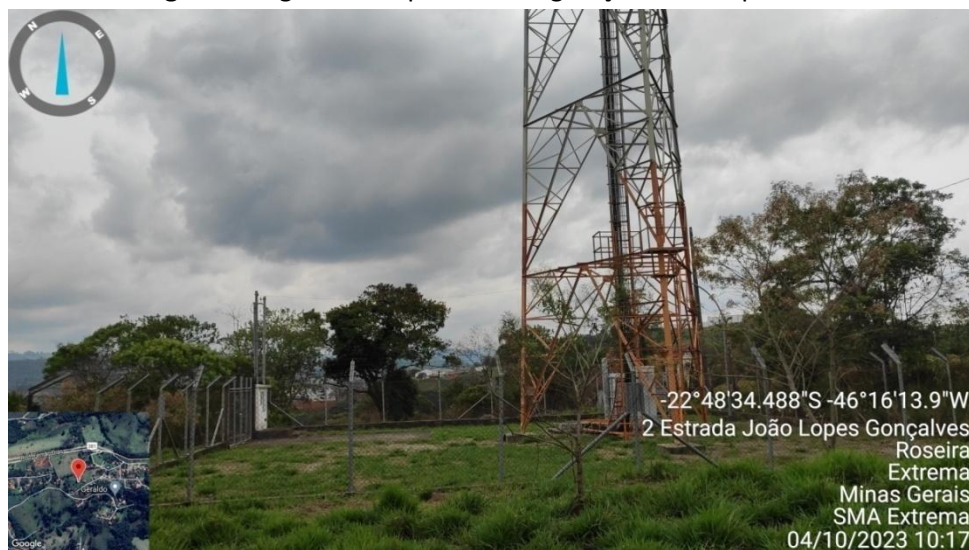
Figura 9. Torre de telefonia a ser desinstalada
