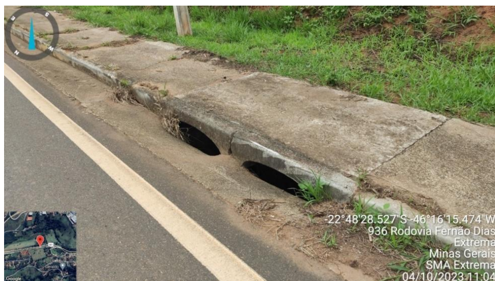
Figura 6. Drenagem da Via a Leste
