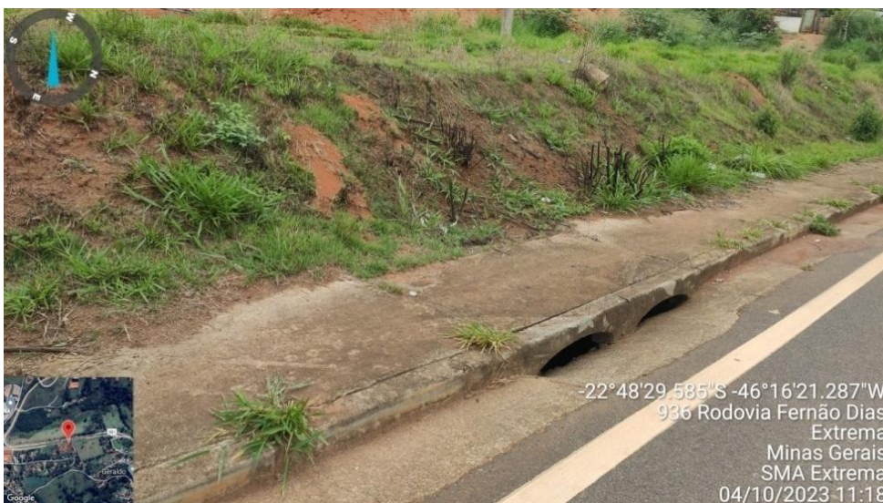
Figura 7. Drenagem da via a Oeste
